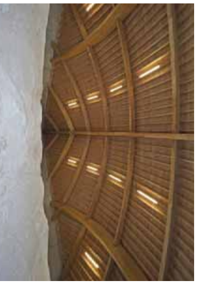
Zoutloods in Breda met gelamineerde spanten van inheemse lariks en verduurzamde Nederlandse douglas voor het dakbeschoot
