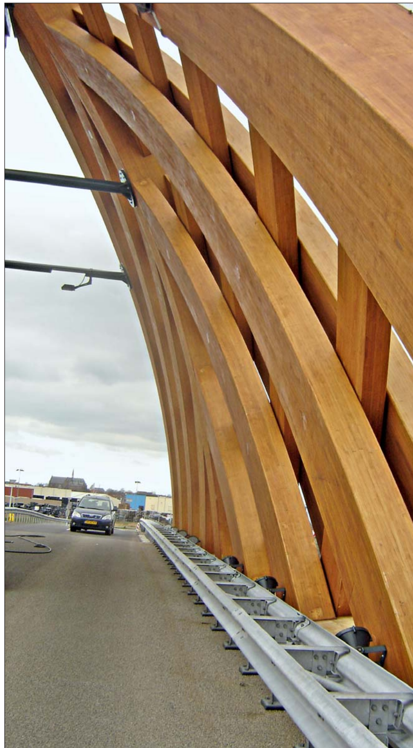
Verkehrsbrücke über die A7 bei Sneek, hergestellt aus modifiziertem Holz (Acocoya) und für die höchste Verkehrsklasse ausgelegt Foto: SHR Hout Research).
