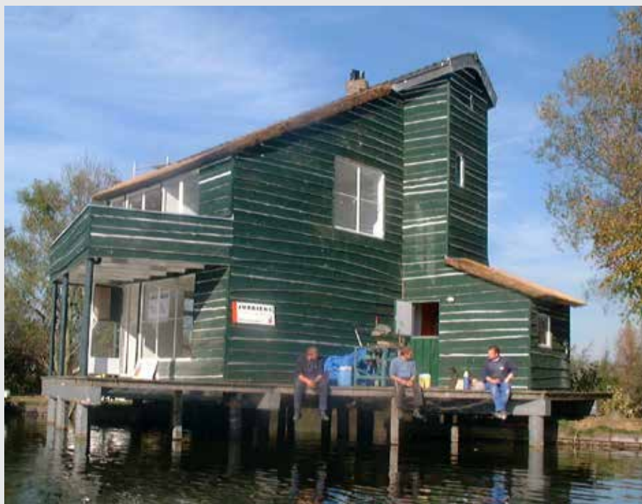
Gewaterd grenen in Rijksmonument de Braamakker (foto bron: https://www.houtzagerijtwickel.nl/Projecten/Braamakker )
