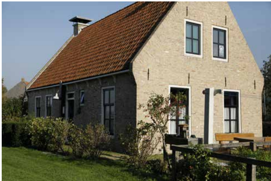
Gewaterd grenen kozijnen in nieuwbouw (foto Mark van Benthem, Probos)
