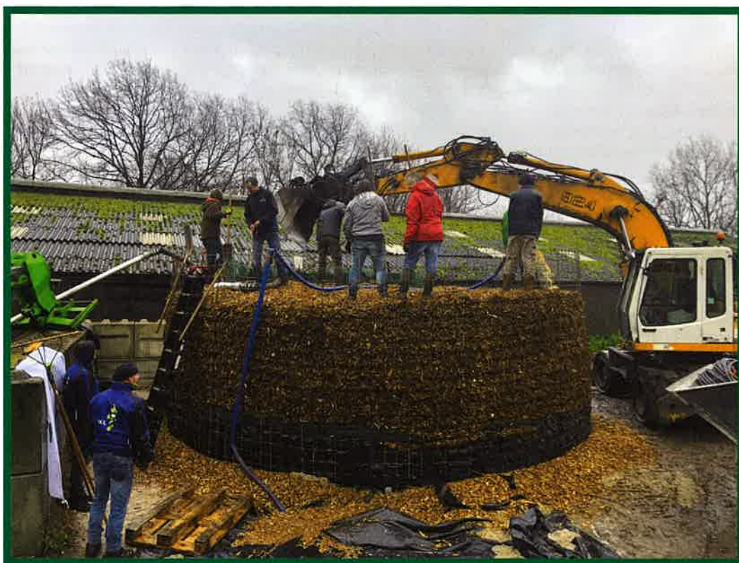
In Voerendaal werd snoeisels van hagen en struiken uit de omgeving verzameld en verwerkt in een biomeiler. De biomassa gaat broeien in de biomeiler, waarna de ontstane warmte wordt gebruikt om een nabijgelegen gebouw te verwarmen. Om het gebouw te verwarmen zou anders de uitstoot van 18,3 ton CO 2 plaatsvinden door de verbranding van aardgas.
