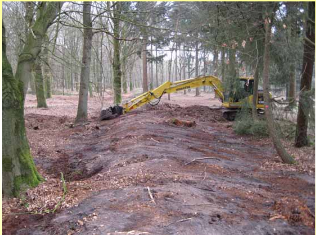
Graafmachine schraapt de strootisellaag eraf
